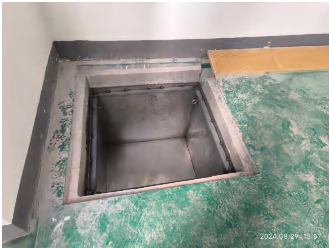
图4-14 危废仓库内收集沟照片
