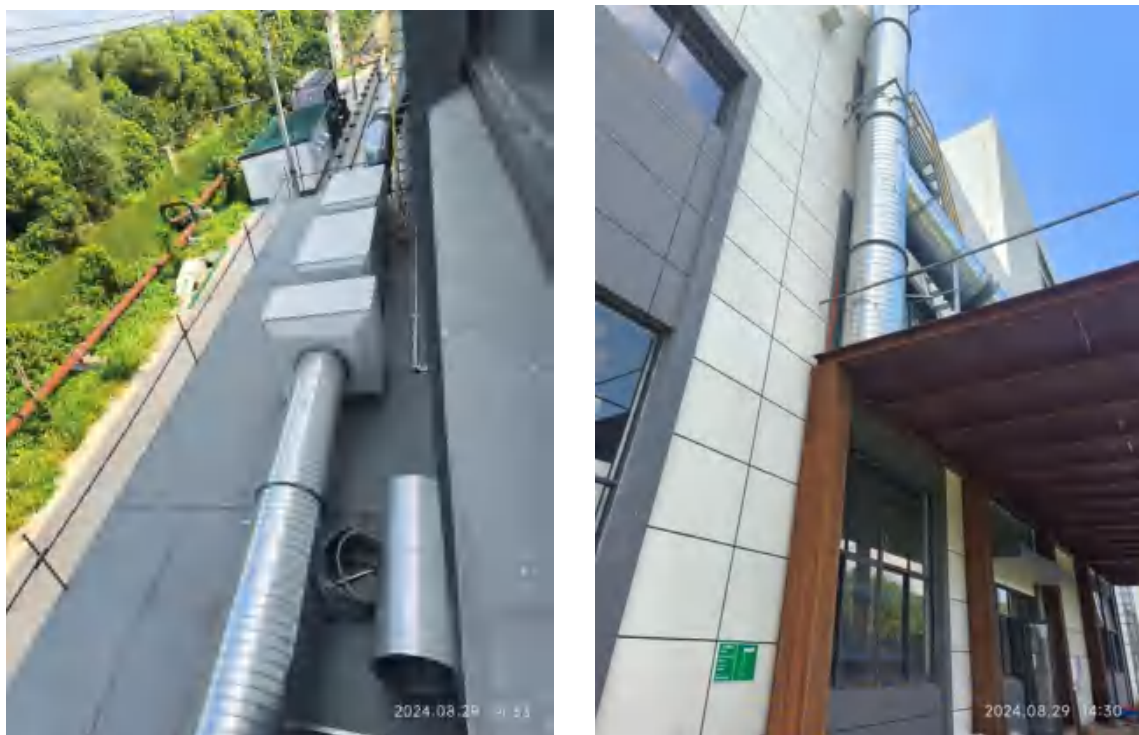
图4-7 二级活性炭废气处理装置及P2-4采样口照片
