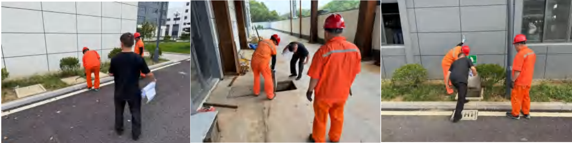
管网验收现场
