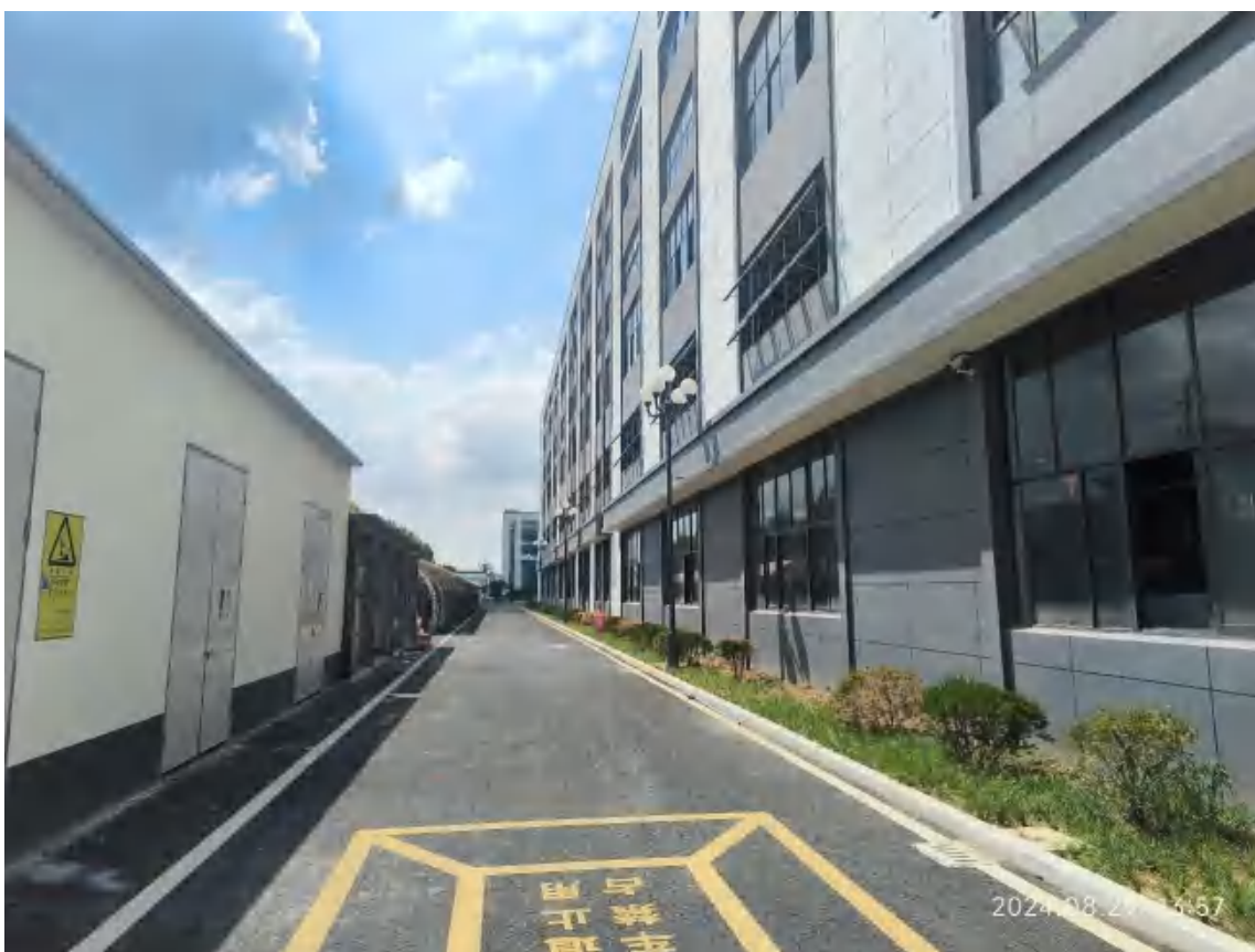
图4-12 危废仓库门口照片（含门口摄像头）
